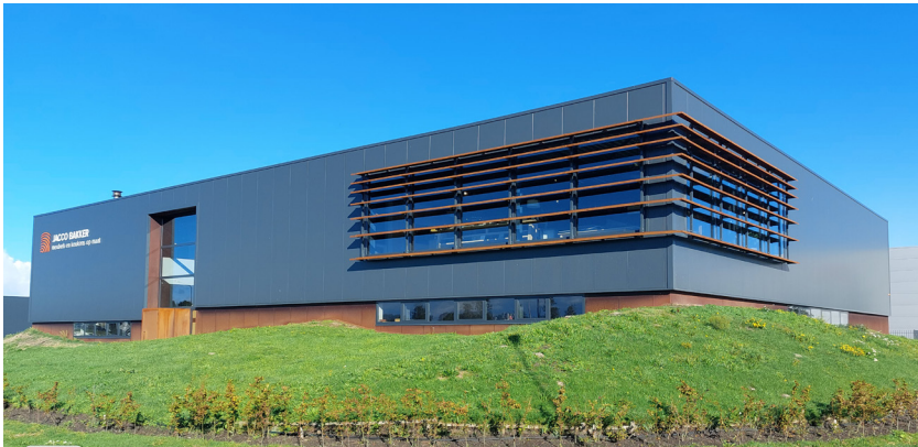
gebouw als monoliet op De Vaandel Midden
