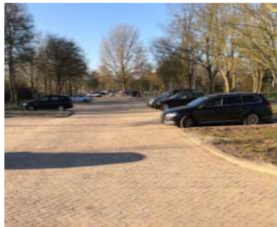
Foto: voorbeeld van dezelfde locatie in Nieuw-Vennep, bestraat met hergebruikte betonnen straatstenen.
